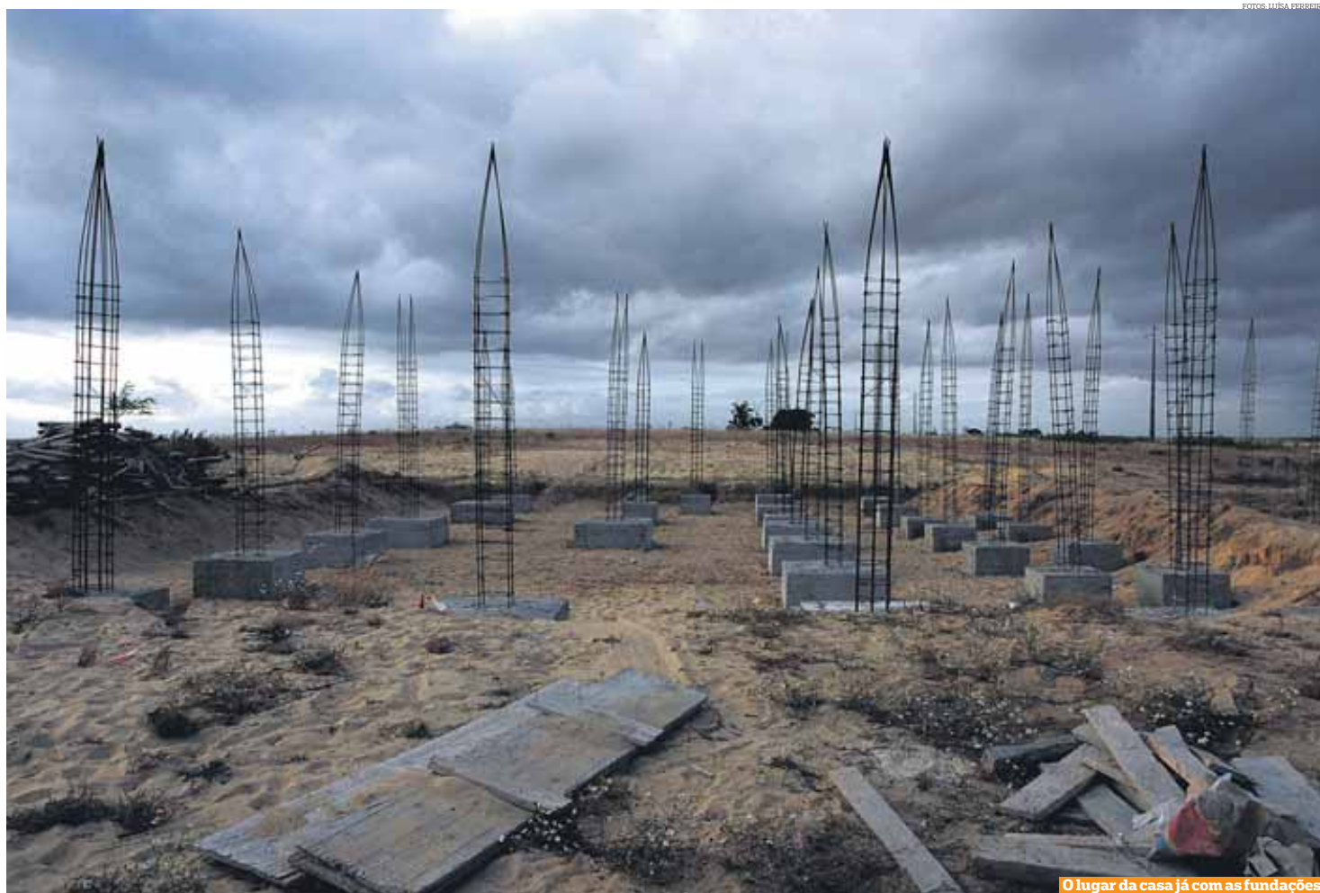
O lugar da casa já com as fundações
